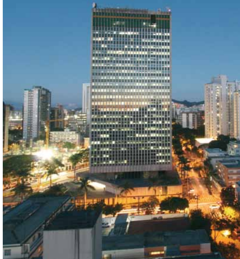
Sede da Cemig, em Belo Horizonte
