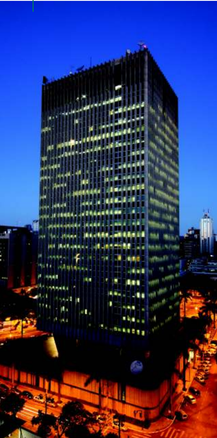
Sede da Cemig, em Belo Horizonte.
