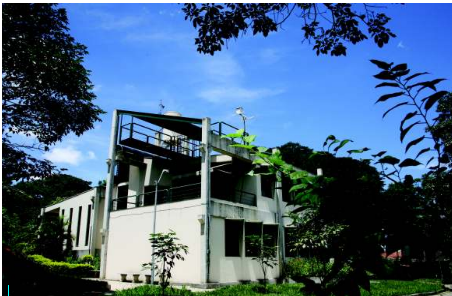
CPEI: prédio construído inteiramente de acordo com a arquitetura bioclimática.
